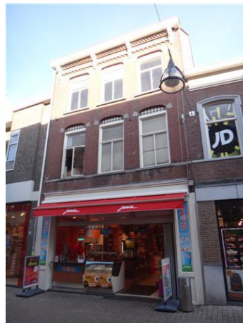
Foto uit 2013 voor de derde bouwlaag
