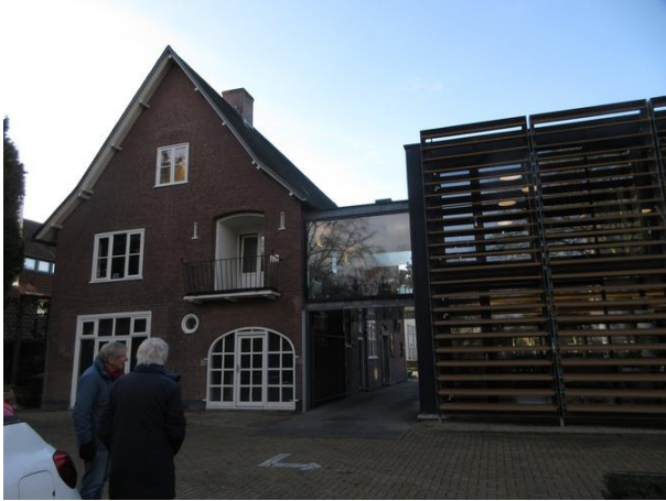
Ringbaan West 242-240 B Achterzijde
