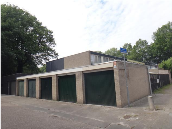
Kasteel Doorwerthstr 1a-e garages, type B (foto 2014)
