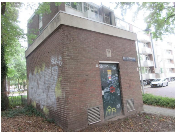
A v Bernestr 197 trafo
