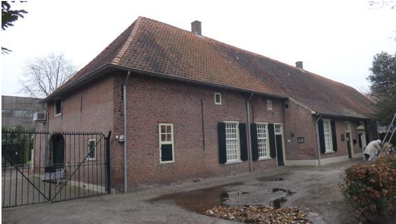
R Hoevenstr 30-30a oliemeulen (foto 2014)
